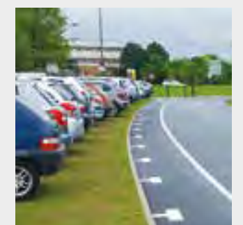
MARQUAGE EN T - PEINTURE SUR ENROBÉ
