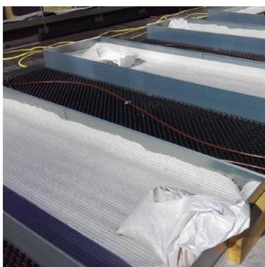
4 - Pose de la natte pour une meilleure irrigation par capillarité des plantes sur le drain au fond des bacs.
