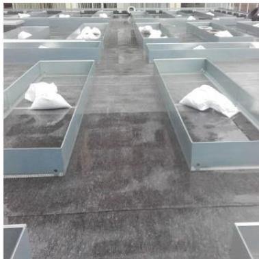
2 - Mise en place des bacs de plantation en magnésis non corrosifs d'une hauteur de 25 à 35 cm.
