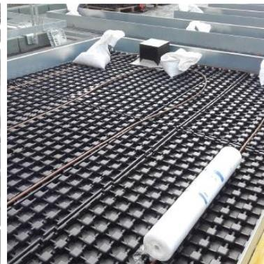
3 - Le système de drainage à forte rétention d'eau des jardinières, et les tuyaux d'irrigation.
