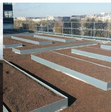
6 - Remplissage de substrat préparé par l'apport d'une vie bactérienne et de vers de terre avant la plantation.
