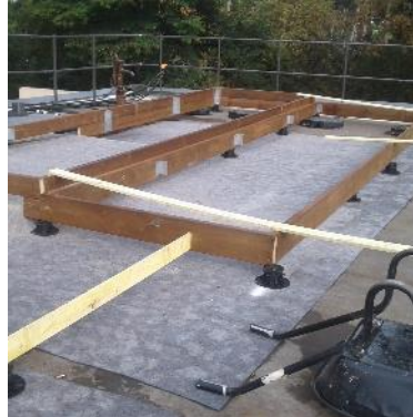
2 - Mise en place des bacs de plantation en pin traité posées sur des dalles sur plots réglables.
