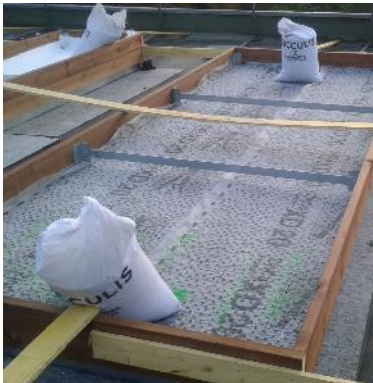
4 - Pose du drainage XD20 dans les jardinières de vivaces et de l'AQUAFLEECE.
