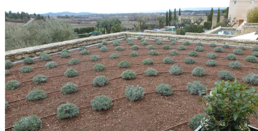
En fonction du type de végétaux choisis et de la zone géographique (méditerranéenne, soumise à de forts vents...), certaines toitures végétales ont besoin d'un arrosage automatique. Le type de système d'irrigation sera défini par l'ingénieur en toiture végétale en fonction du projet.
