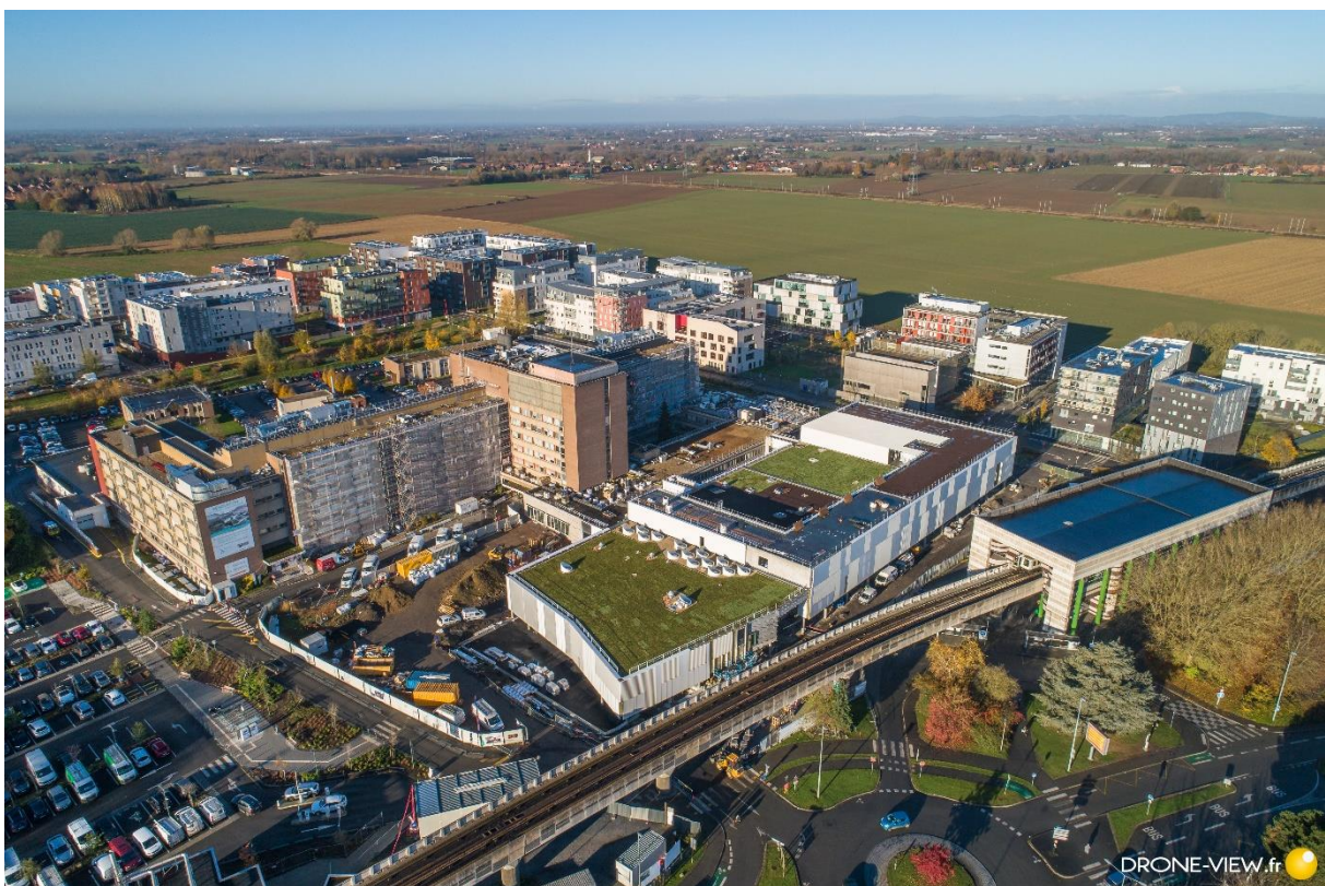
Vue aérienne de l'hôpital - © André-Marie DUTRIEUX - Drone-view Moretti constructions – Ramery -G.O-architectes
