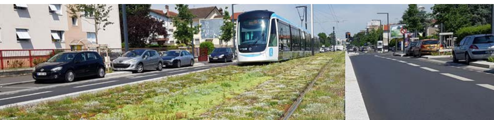
STABILISATION DE SOLS
