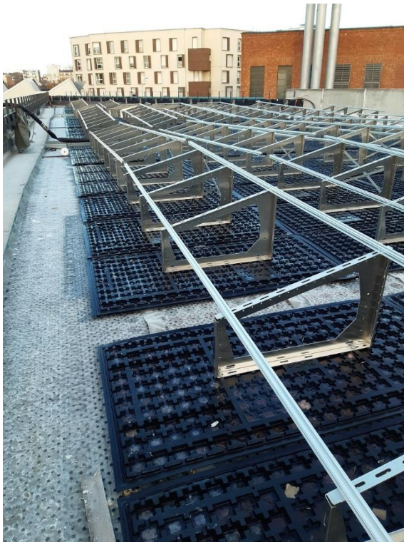
Photo à la mise en œuvre en déc 2021
