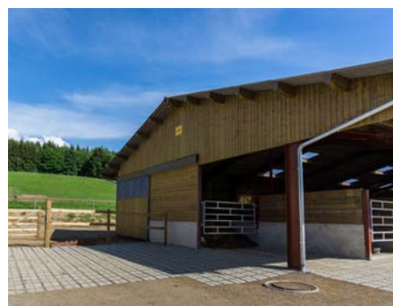
Cours de ferme et aires de stockage
