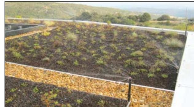
La plupart des toitures végétales inaccessibles ne nécessitent pas d'apport d'eau supplémentaire. Le système est conçu pour être auto-suffisant. Néanmoins certaines configurations requièrent une **irrigation raisonnée** pour garantir une pérennité des végétaux et une réussite durable.
